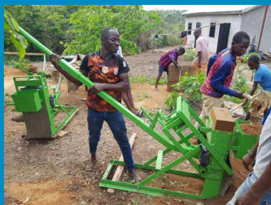
La confection de briques sur place a facilité la construction des bâtiments.
